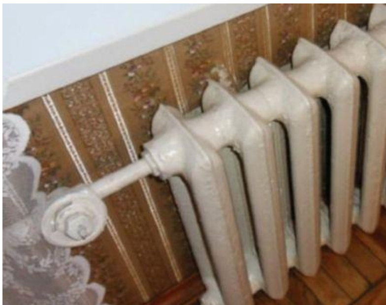
Рис. 1. Много лет не используемый радиаторный клапан
